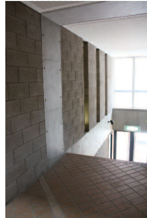
2階～1階入口を見下ろす
